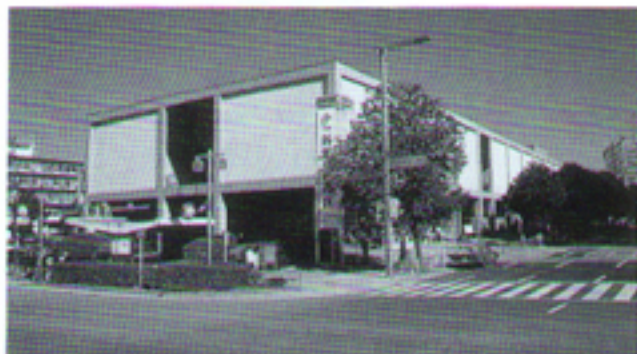
旧愛知県美術館（愛知県文化会館）
