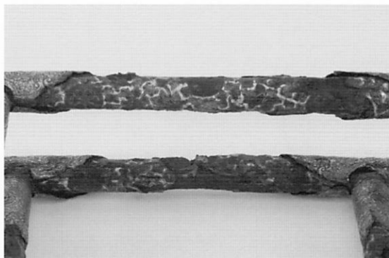
二本の地覆棧と筒型八双金具処置後
